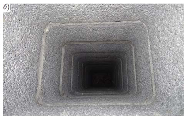
Рис. 3. Вентиляционные блоки «Полигран» в сборе при испытаниях на герметичность: а — внешний вид вентблоков при испытаниях; б — вид сборного канала-сборника изнутри; 1 — вентиляционный блок на клею с затиркой клеевой смесью; 2 — вентиляционный блок на растворе с затиркой цементно-песчаным раствором
